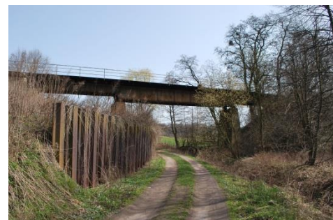
Rys.28. Wiadukt w Pszowie 2016 r.
