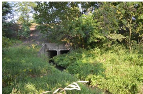
Rys.18. Przepust dla potoku syrynka pod torowiskiem w miejscu mostu.
