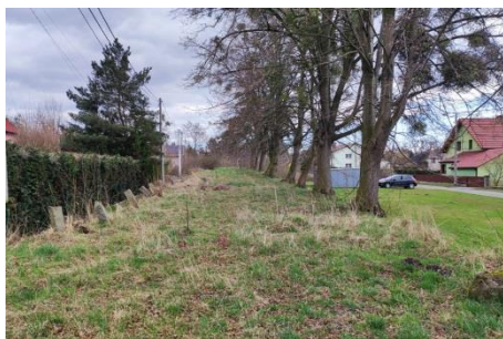
Rys. 13. Droga na Wiadukt 2 w Bluszcówie od południa w 2023 r.
