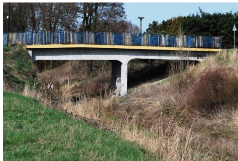
Rys.10. Wiadukt w Bluszcówie 2016 r.
